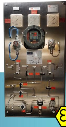
La platine H<sub>2</sub>-O<sub>2</sub> analyse en continu la concentration en hydrogène et en oxygène du circuit de refroidissement de l'alternateur durant toute la phase de production et lors de la mise en air par chasses successives. Elle détecte avec précision l'apparition des mélanges gazeux hydrogénés potentiellement explosifs et permet aussi d'écarter le risque d'anoxie par la mesure du niveau d'oxygène lors de l'ouverture du circuit.
